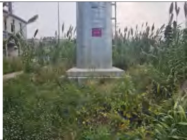
塔基迹地现状（二）
