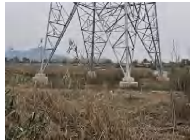
塔基迹地现状（三）
