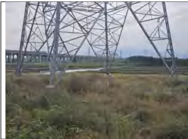
塔基迹地现状（一）
